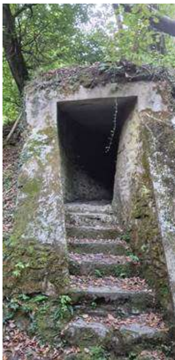
Figura 1 Ingresso del tunnel sul terreno
