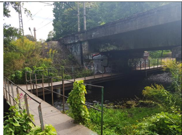
Location A , vista da NW
