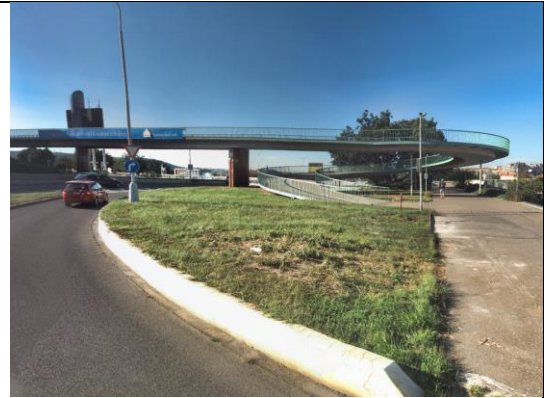
Location A Ponte a spirale, vista da SE
