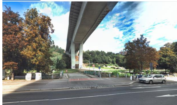
Location E , vista da S
